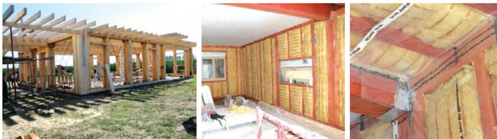
*Slika 27* Primjeri konstrukcije, ispune te izvedbe parne brane s unutarnje strane drvene kuće građene kanatnim sustavom
