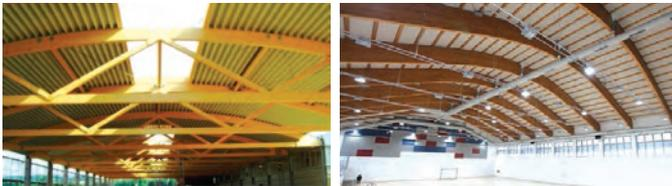
**Slika 29** Primjeri drvenog rešetkastog nosača i lučnog nosača od lijepljenog lameliranog drva
