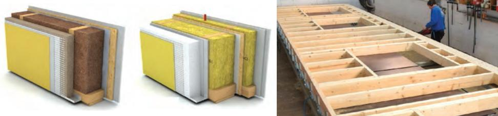
*Slika 16* Moguća rješenja toplinske izolacije montažnih zidova, izrada zidova u tvornici
