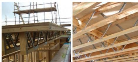
Slika 14 Lagani nosači s drvenim pojasnicama i čeličnim dijagonalama
