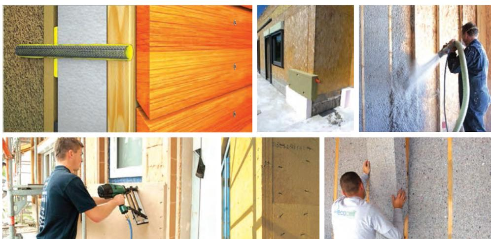
Slika 49 Primjeri načina pričvršćivanja izolacije za drvenu konstrukciju
