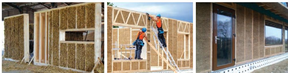
Slika 79 Slama kao ispuna drvene nosive konstrukcije
