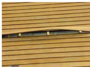
*Izvijanje daske vanjske obloge*
