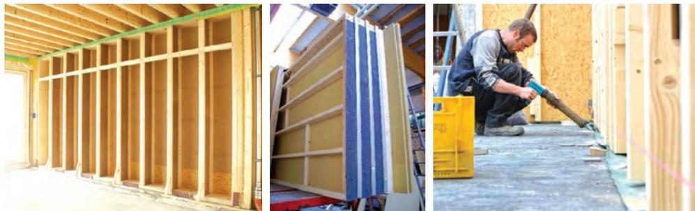
*Slika 56* Primjeri dobrog planiranja i pripreme olakšava brtvljenje zrakonepropusne ovojnice
