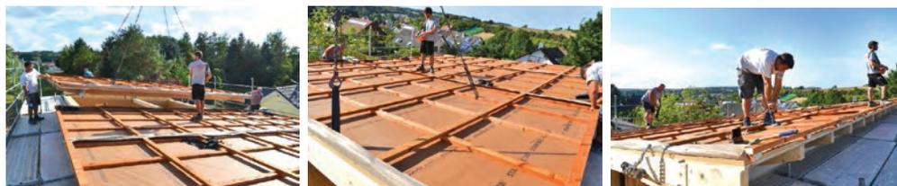
*Slika 76* Primjer izvedbe ventiliranog krova s pokrovom od trapeznog lima korištenjem predgotovljenih krovni elemenata
