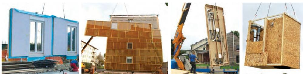
*Slika 31* Primjeri drvenih montažnih panela
