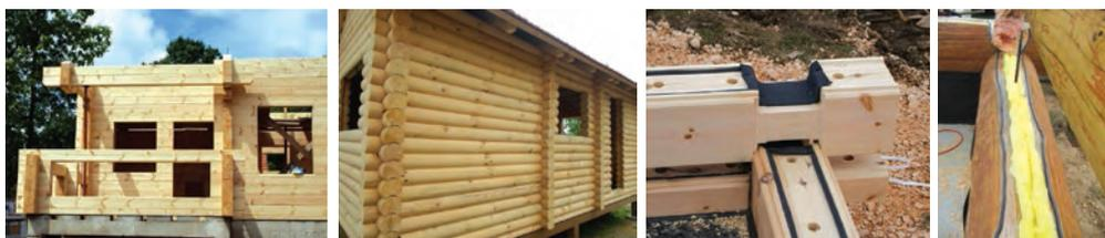
*Slika 26* Primjeri sustava punih drvenih stijena i načina brtvljenja
