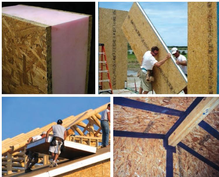
*Slika 15* Drveni SIP paneli, montaža i brtvljenje
