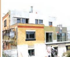
Izvođenje ETICS sustava na vlažnu podlogu od OSB ploča
