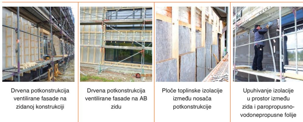
**Tablica 13** Izvedba potkonstrukcije za ventiliranu fasadu
