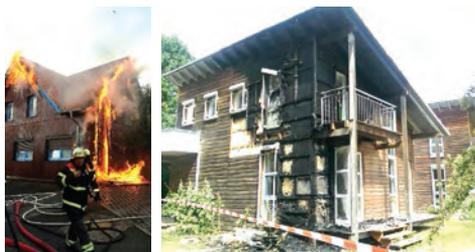
**Slika 66** Primjer požara koji su se proširili po fasadi drvene zgrade
