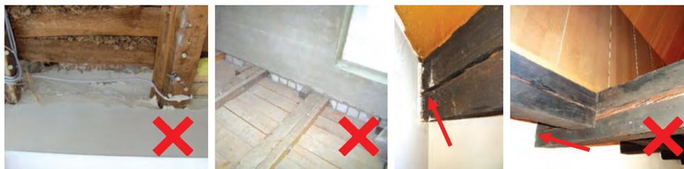
*Slika 57* Primjeri nezabrtvljenih proboja greda drvenih stropova prilikom energetske obnove zgrade
