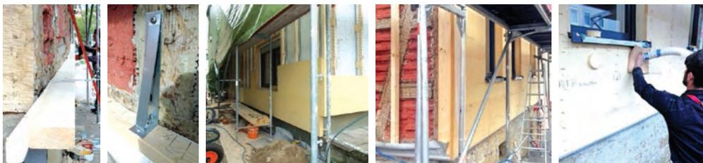
*Slika 86 Prikaz postupka izvođenja toplinske izolacije postojeće zgrade s vanjske strane upuhivanjem rasute toplinske izolacije*
