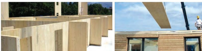
Slika 32 Primjeri gradnje zgrada pomoću križno lameliranih ploča
