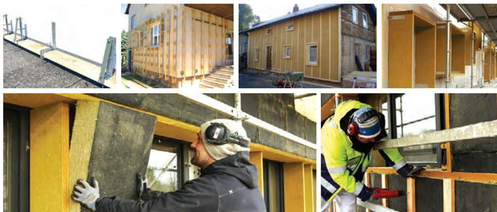
*Slika 87* Prikaz postavljanja drvene potkonstrukcije na postojeću zgradu, ugradnje okvira oko prozora radi lakše ugradnje novog prozora te ugradnje toplinske izolacije i osiguranje sloja ventilirajućeg zraka
